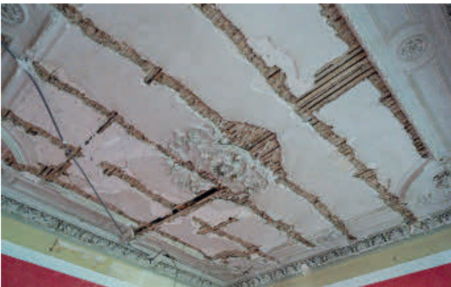
Abb. 78: Stuckdecken in der „Villa Bodinus“. Stucco ceiling in “Villa Bodinus”.
